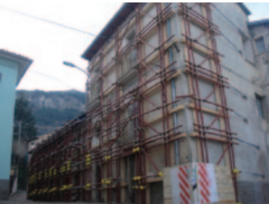
Esempio di cerchiatura con tubi e giunti e cavi in acciaio
