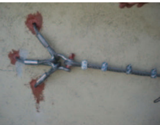
Applicazione tirante con resine
