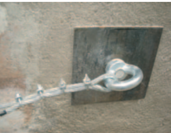
Applicazione tirante con piastra metallica
