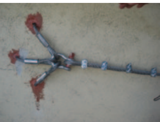
applicazione tirante con resine
