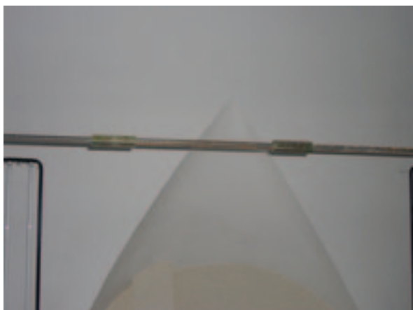
Particolare di un tirante in acciaio
