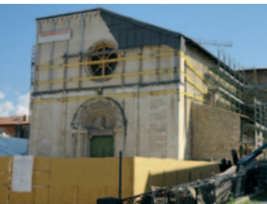
Particolare di fasciatura in poliestere
